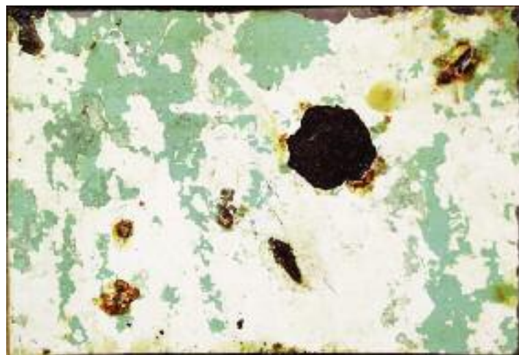
MURO II, detalle del 6to. rectángulo, de la 6ta. fila.
